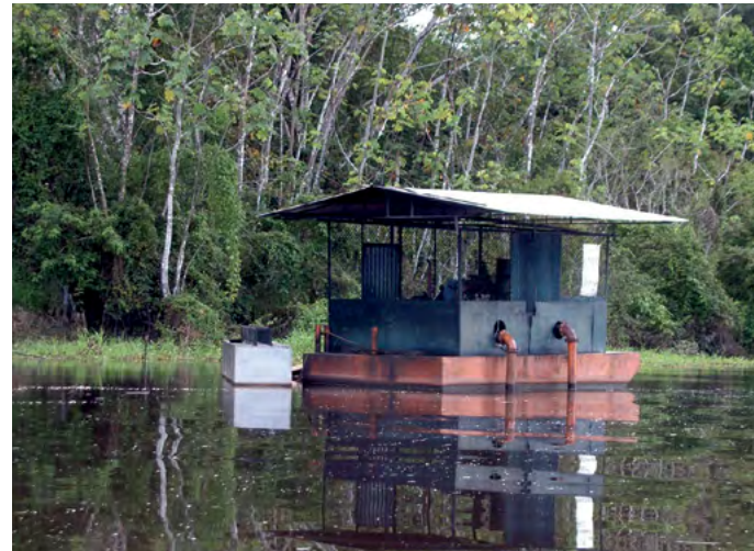
BALSA PARA LA CAPTACIÓN DE AGUA DEL ACUEDUCTO. RÍO LORETOYACU, MUNICIPIO DE PUERTO NARIÑO, AMAZONAS, 2005.
