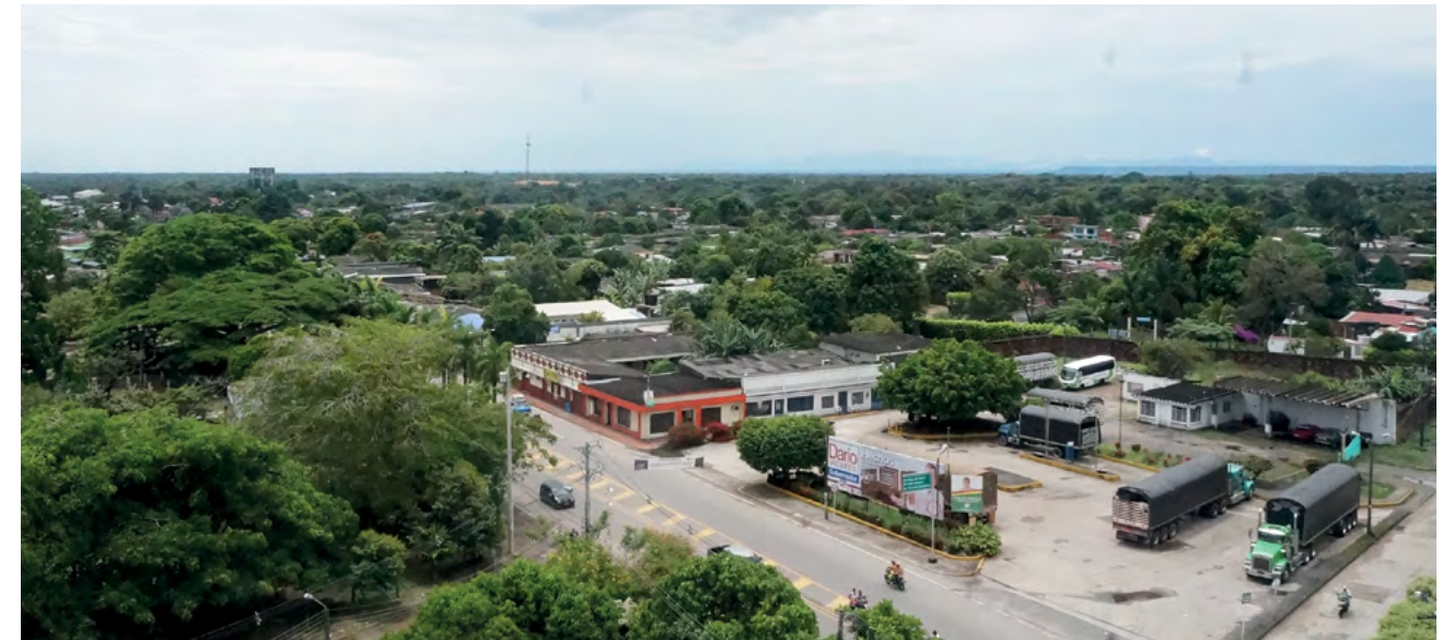
VÍAS EN SAN JOSÉ DEL GUAVIARE, 2015. San José del Guaviare se encuentra a 380 km desde Bogotá y se une por vía terrestre con El Retorno y Calamar.
