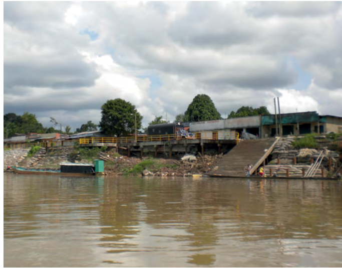
PUERTO DE MAPIRIPÁN, META, SOBRE EL RÍO GUAVIARE, 2010. En Mapiripán el puerto de acceso constituye la gran fachada del centro urbano sobre el río.
