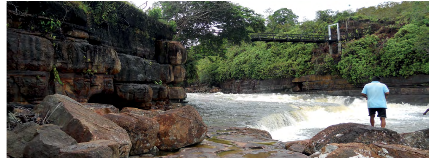
VISTA DEL PUENTE SOBRE EL RÍO IGARA PARANÁ Y LOS “CHORROS” QUE DAN EL NOMBRE AL CORREGIMIENTO DE LA CHORRERA, AMAZONAS, 2011.
