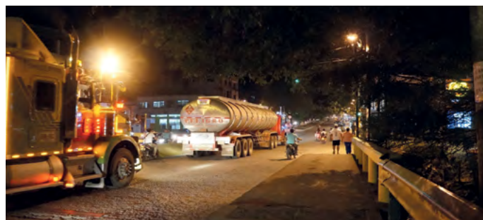
PUENTE SOBRE EL RÍO SANGOYACO, MOCOA, 2013. Las vías ya deterioradas del centro de Mocoa, soportan tráfico pesado.
