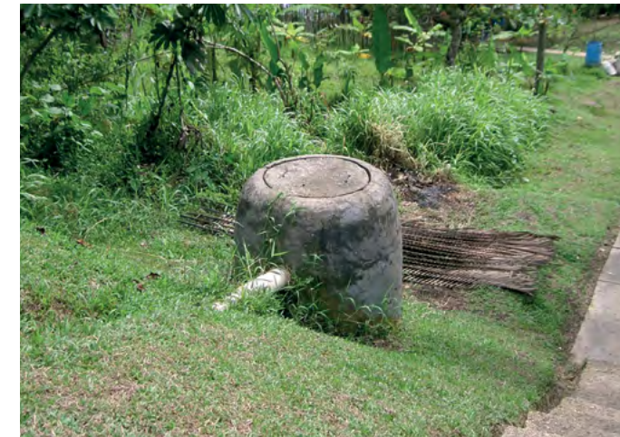
RED DE ALCANTARILLADO EN PUERTO NARIÑO, AMAZONAS, 2005.
