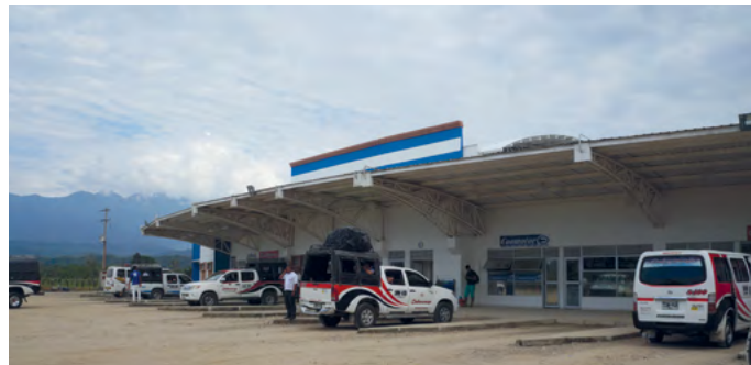
TERMINAL DE TRANSPORTE DE VILLAGARZÓN, PUTUMAYO, 2015.
