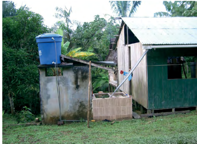
MÓDULO DE SANEAMIENTO BÁSICO PARA UNA VIVIENDA EN EL ÁREA URBANA DE PUERTO NARIÑO, AMAZONAS, 2005.
