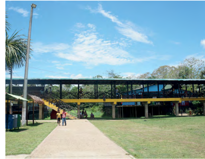
PUENTE-MUELLE Y ANDENES, PUERTO NARIÑO, AMAZONAS, 2016. El puente-muelle de Puerto Nariño responde a las condiciones del lugar en aguas altas y bajas.
