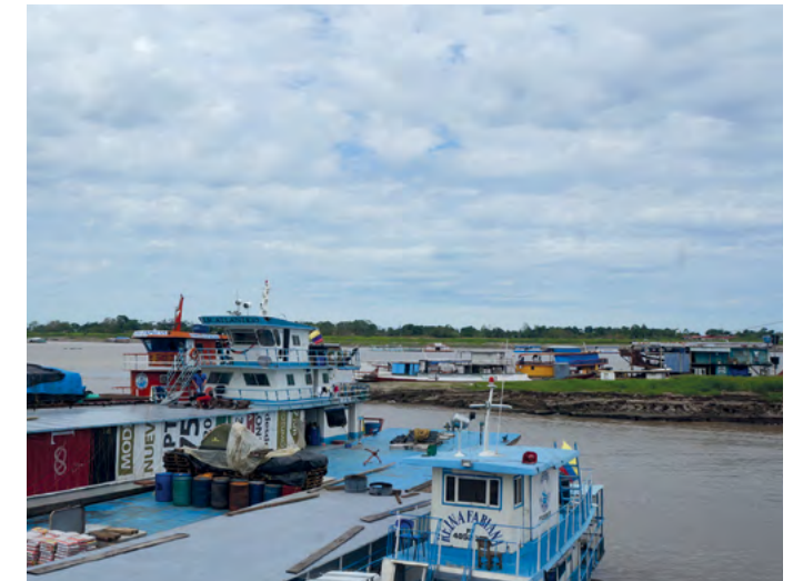
MUELLE DE LETICIA, AMAZONAS, 2009. El muelle de Leticia se ve afectado en su funcionamiento por la sedimentación del río.
