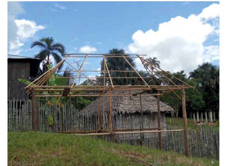
CASA EN CONSTRUCCIÓN EN LA CABECERA DEL CORREGIMIENTO DEPARTAMENTAL DE LA CHORRERA, AMAZONAS, 2011. Los seres humanos obtienen del medio natural materias primas, diversidad de materiales para construcción y combustibles.
