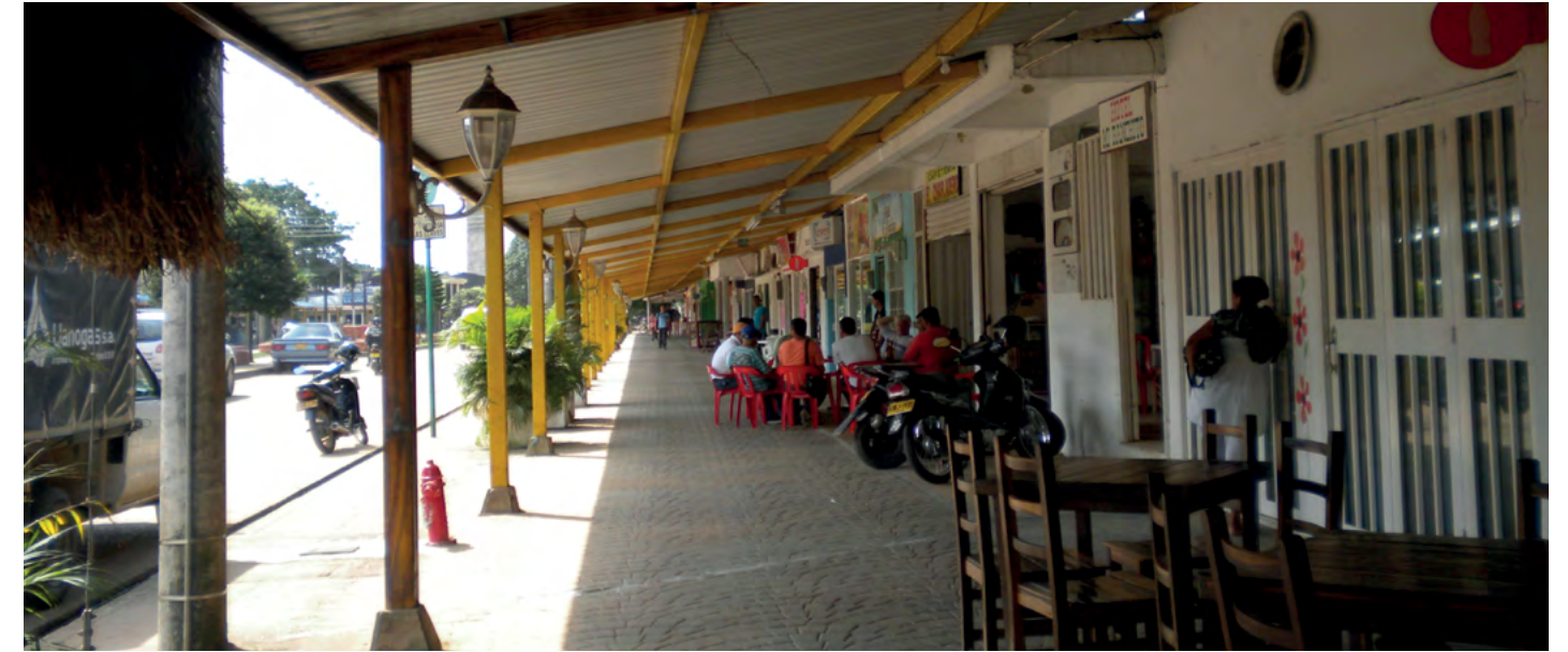
SAN JOSÉ DEL GUAVIARE, GUAVIARE, 2010. En el centro de San José del Guaviare se destaca el manejo del espacio público con andenes cubiertos.
